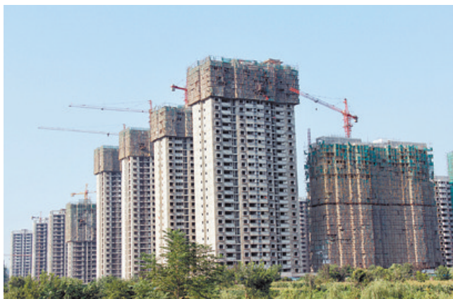
二号福民安置小区建设如火如荼。
