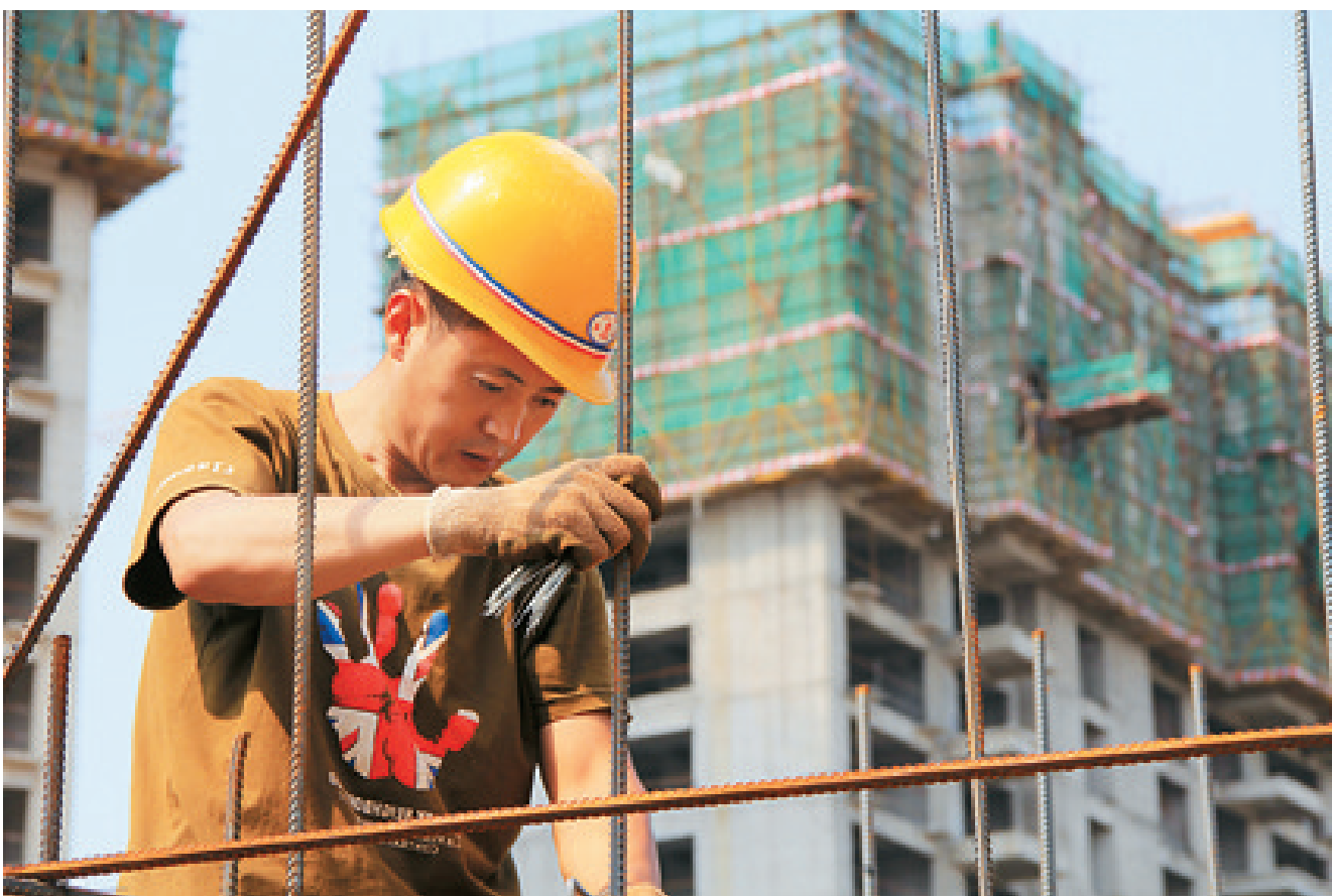
九嘉伊滨花园项目建设现场,工人正在加紧施工。
