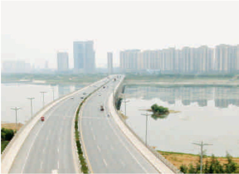
洛偃快速通道跨伊河大桥
