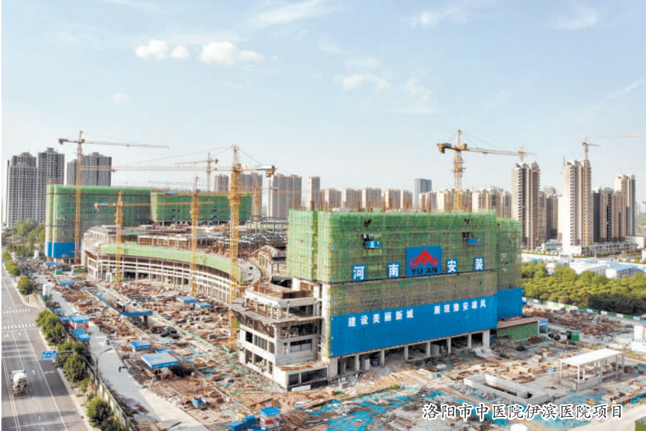
洛阳市中医院伊滨医院项目
