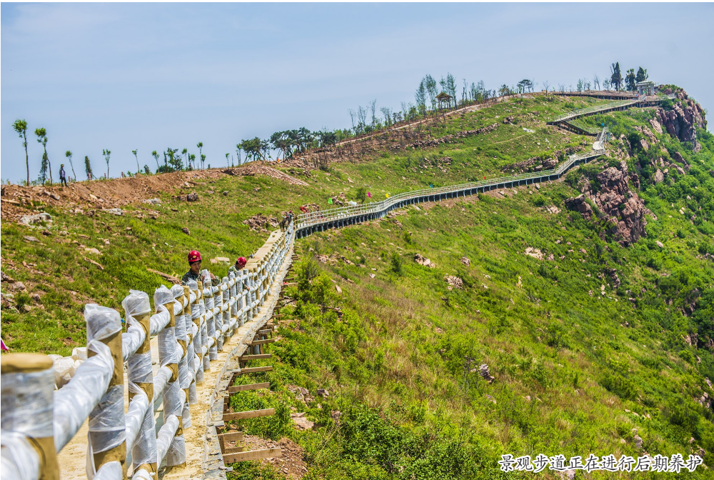
景观步道正在进行后期养护
