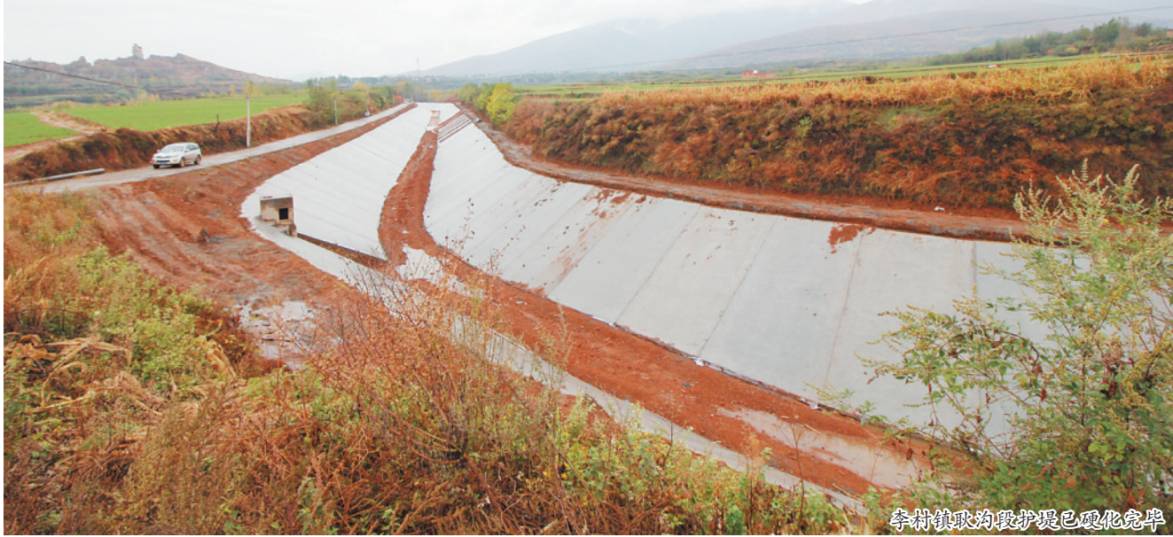
李村镇耿沟段护堤已硬化完毕
