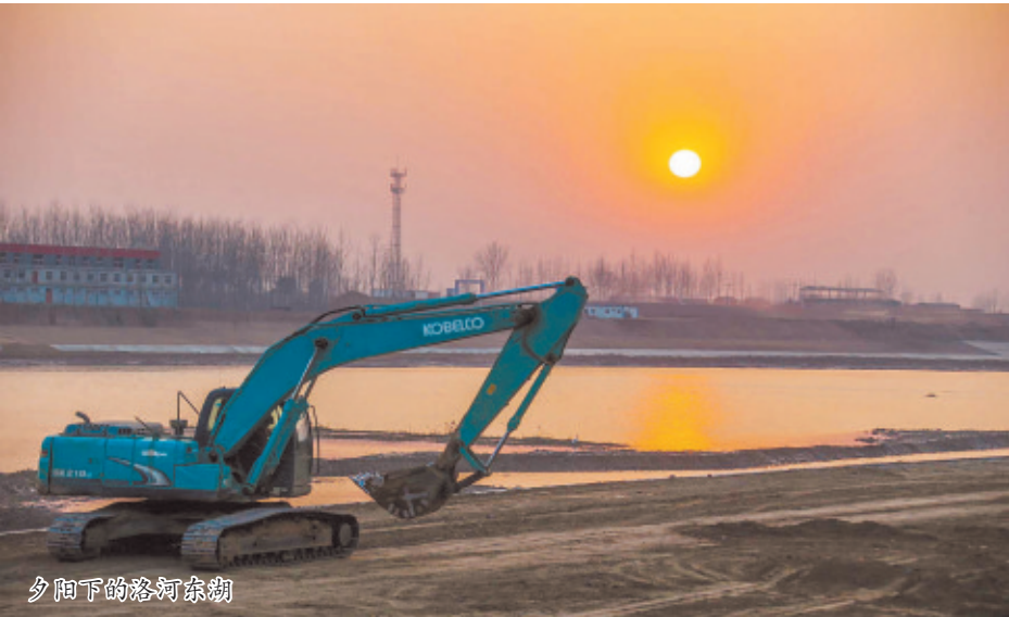
洛河东湖正在进行拦河坝防洪坡施工
