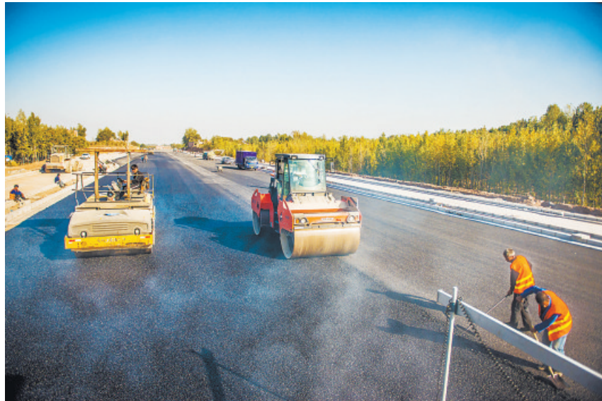
10月12日,我区玄奘路正在加紧施工,图为压路机正在平整地面
