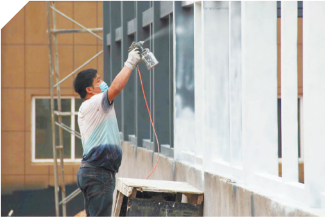
地下车库出口正在进行收尾喷漆
