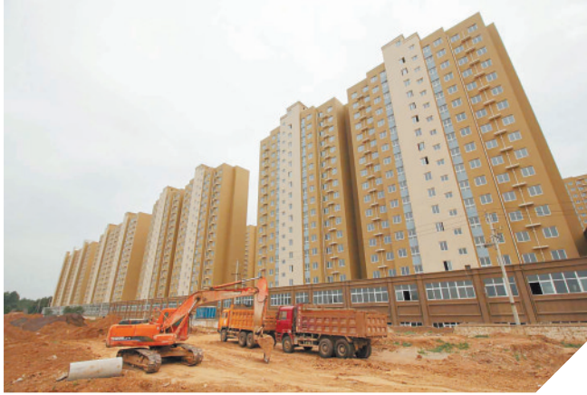
小区外围建筑垃圾清理已基本结束
