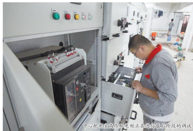
中心配电室高压配电柜正在进行最后阶段的调试
