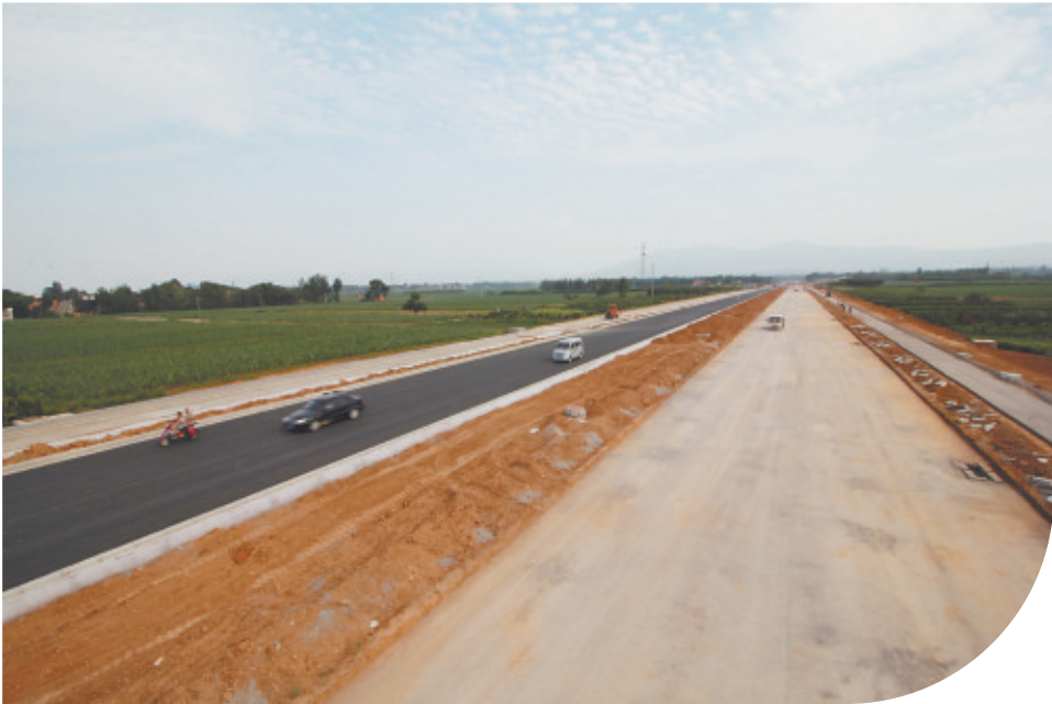
东半幅主干道沥青已铺设完毕
