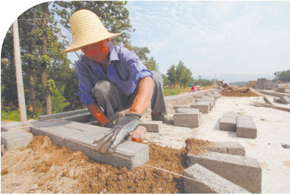
人行道正在铺设
